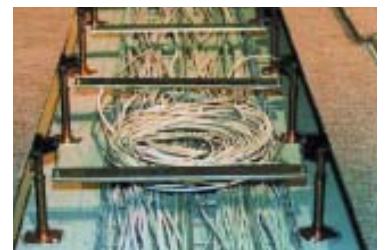
Offener Doppelboden vor dem Verschießen. Die Auflageprofile für die Wärmedämmkassetten sind bereits montiert.
